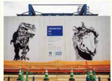
工事現場の仮囲いに展示された「障がい者アート」
